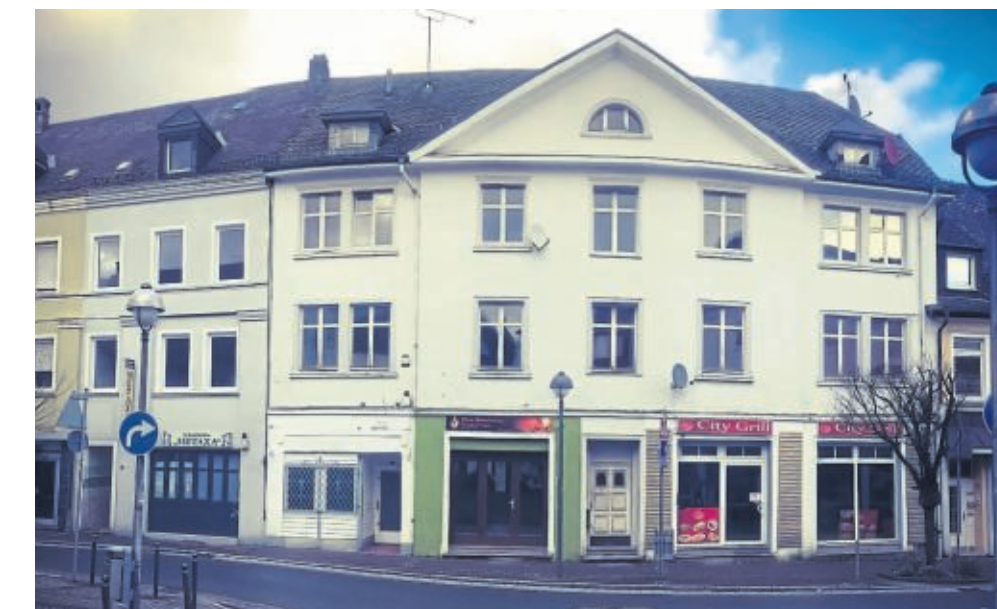
Die beiden Häuser an der Hauptstraße sollen saniert werden – während dieser Zeit können sie nicht genutzt werden. FOTO: F. ZACHARIAS
